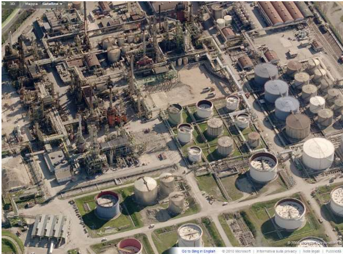
Figura 6. L'impianto della Raffineria
