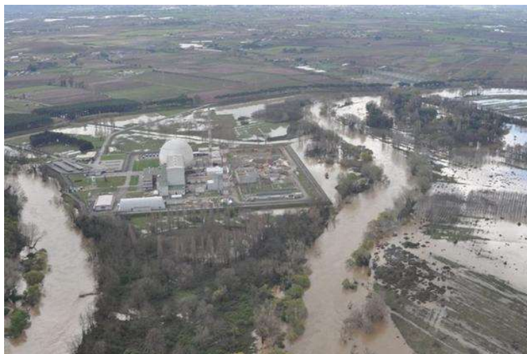
Figura 18. Allagamento della ex centrale nucleare Garigliano (2009) (72)
